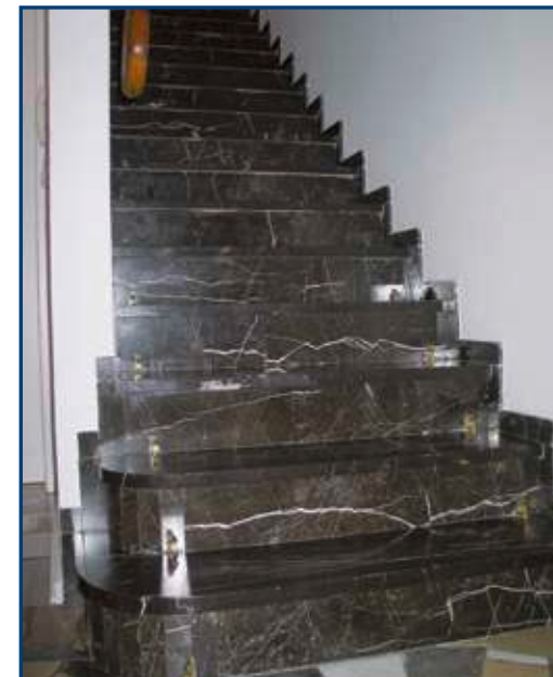
107) Treppe im Haus Lücke
