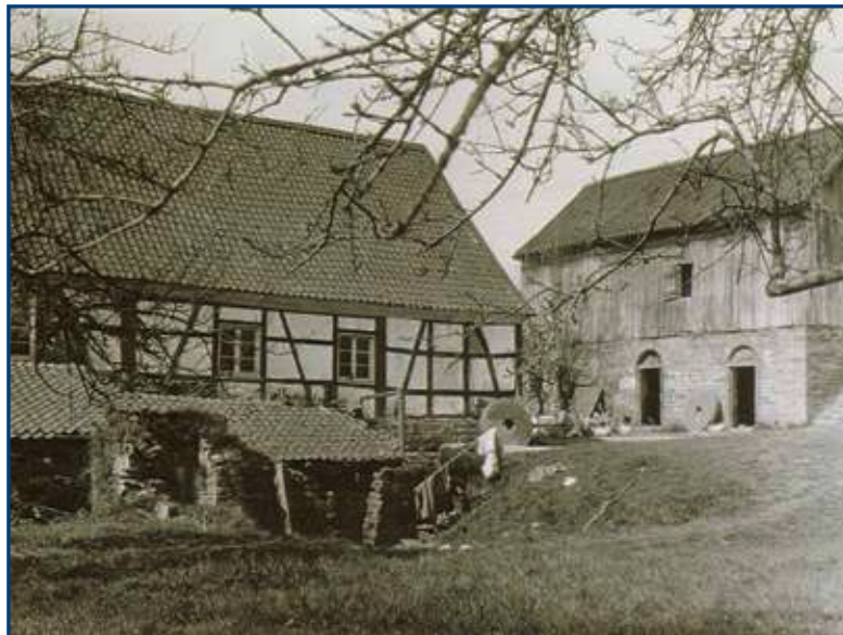
86) Hartegasser Mühle von Nordost
