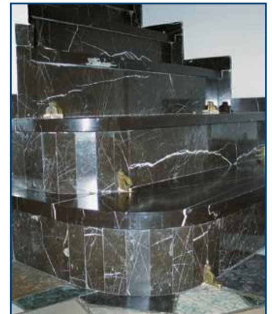
108) Treppe im Haus Lücke
