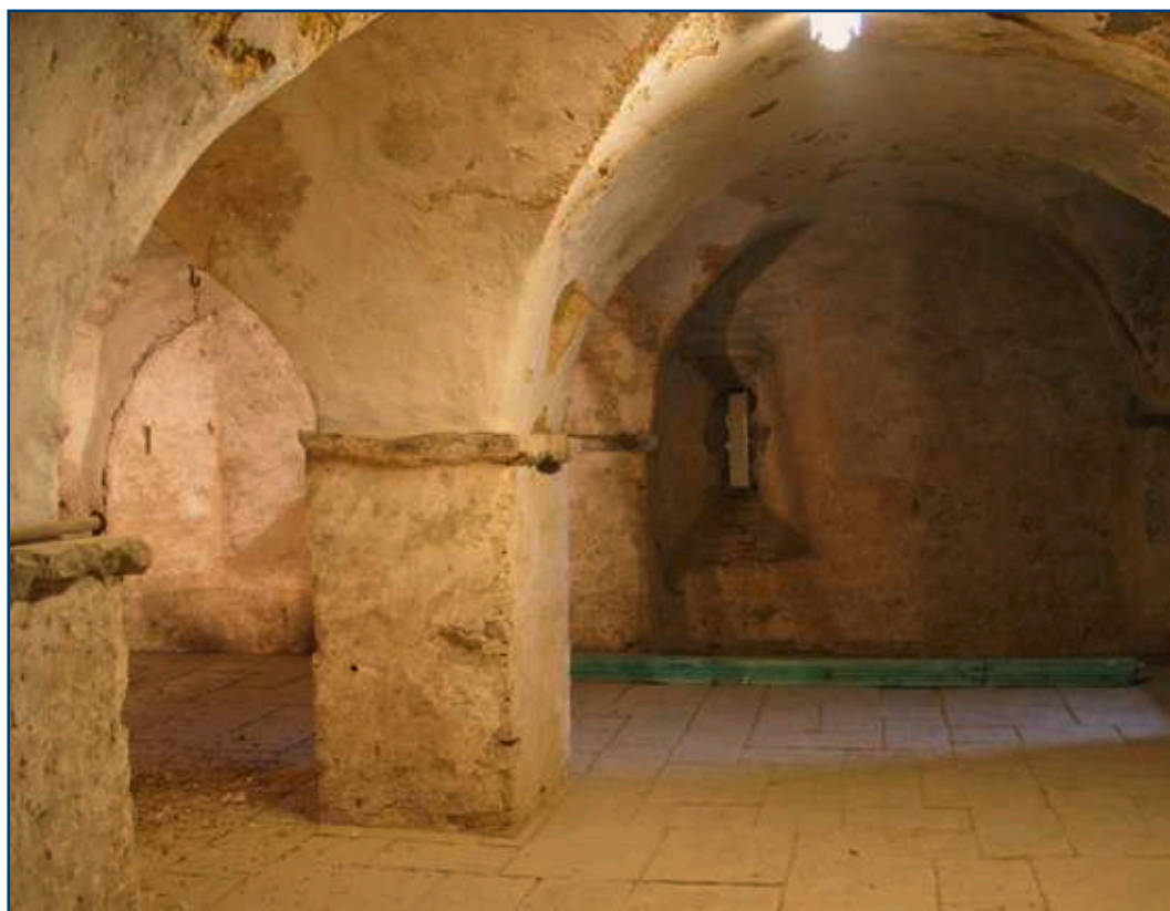
12) Gewölbekeller in der Burg Oberbreidenbach
