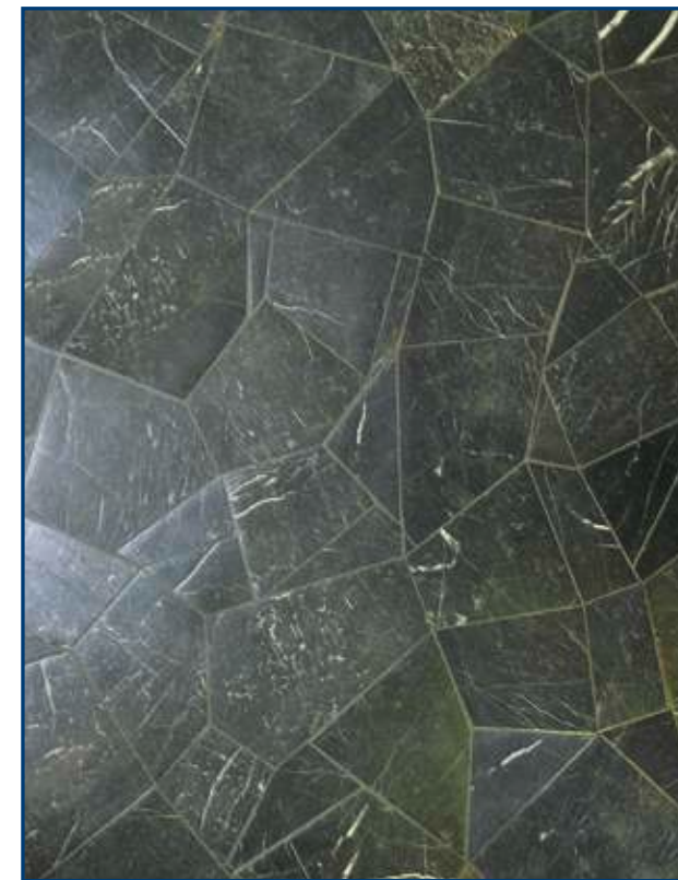
95) Die Fußbodenplatten im Erdgeschoß
