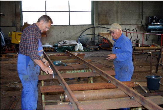
Geleise richten im Torfwerk
