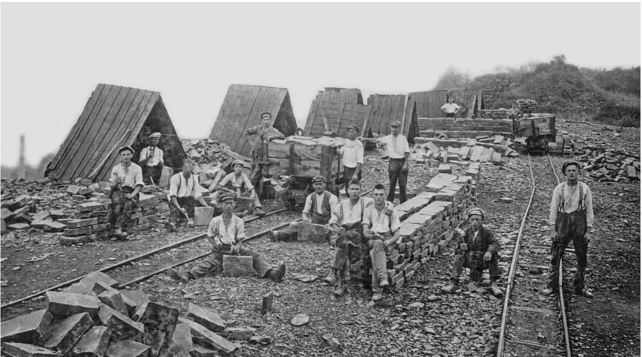
Steinhauerabteilung, die im Akkord Mauer- und Pflastersteine fertigt. Die Brettverschlage („Kipperhutten“) sollten Personal und Material vor ungunstigen Witterungseinflussen schutzen; Lindlar um 1920.
