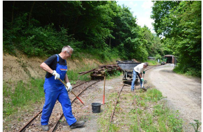
Pflegemaßnahmen an der Gleisanlage
