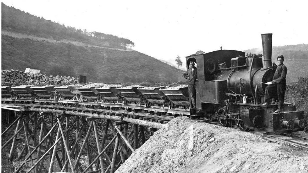
Viele Jahre lang beförderten kleine Dampflokomotiven das Steinmaterial zu den innerbetrieblichen Verarbeitungsstätten oder bis an die Verladestationen der Preußischen Eisenbahnverwaltung; Foto von 1928.
